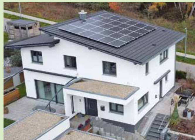
So kann eine fertig installierte PV-Anlage aussehen.
