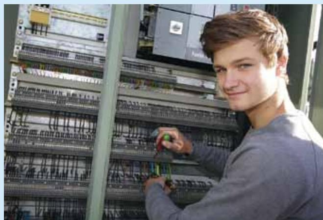
Sven Harlinghausen beim Suchen eines Fehlers im Steuerschrank eines 110kV-Leistungsschalters. Fotos: Lechwerke AG
