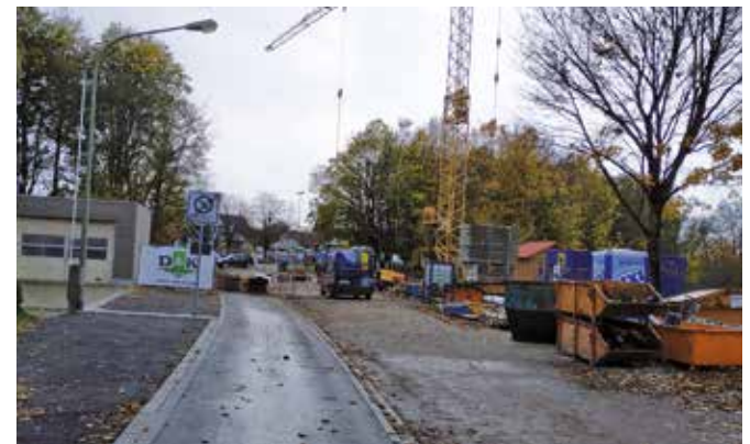
Eine der vielen Baustellen in Memmingerberg, die Sanierung der Augsburgs Straße und die Hainbachbrücke.
