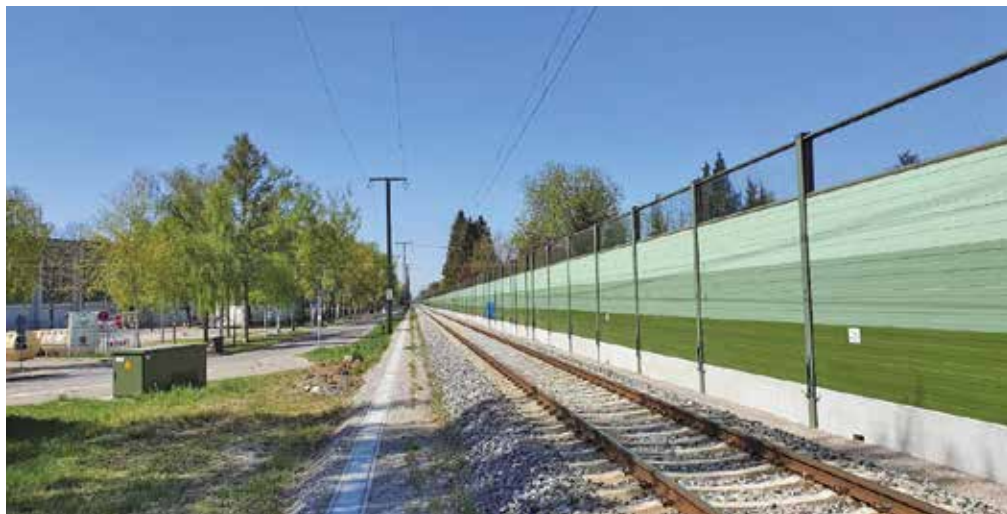
Die bereits elektrifizierte Bahnstrecke am BBZ-Gelände.
