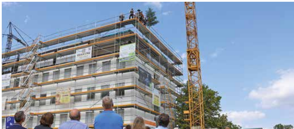
Für das vierte Obergeschoss des Landratsamts wurde Richtfest gefeiert, die Arbeiten sind im Zeitplan. Foto: Landratsamt Unterallgäu
