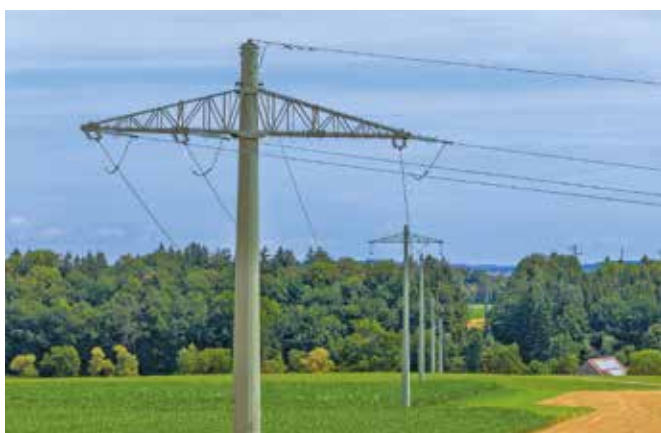
Die Modernisierung der Hochspannungsleitung zwischen Memmingen und Dickenreishausen ist abgeschlossen. Foto: LVN
