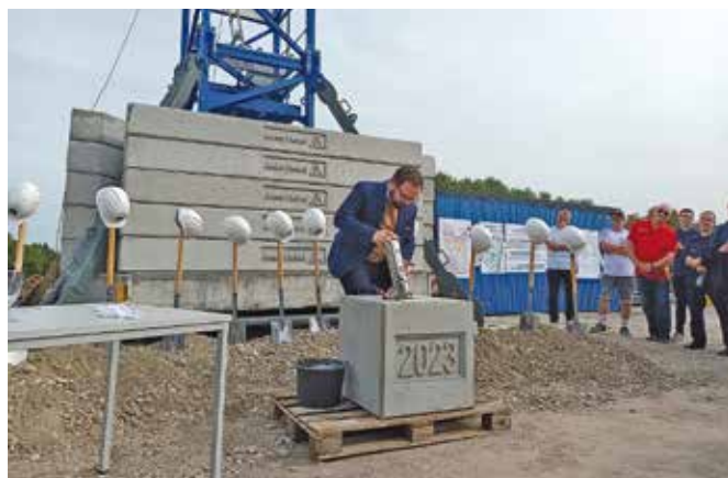
Oberbürgermeister Jan Rothenbacher legte die befüllte, verschlossene Zeitkapsel in den Grundstein für das Kombibad und betonierte diese anschließend darin ein.
