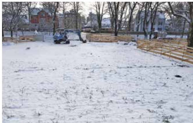
Auf dem Gelände der früheren Turnhalle wird auch der Neubau errichtet. Hölzerne Schutzzäune erhalten den alten Baumbestand in direkter Umgebung der Baustelle.
