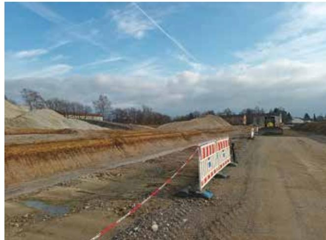
Der ausgehobene Kanal für die drei mal drei Meter großen Rohre auf einer Länge von 360 Metern nimmt sichtbar Form an.
