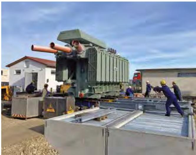
Um den 65 Tonnen schweren Transformator auf seinem Fundament zu platzieren, kam eine Schienenkonstruktion zum Einsatz.
