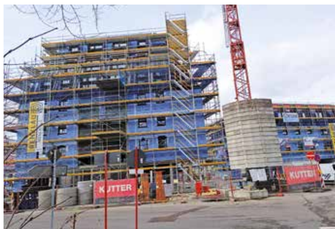
Die sieben- bzw. viergeschossigen Gebäude LEO1 und LEO2 im Süden des Memminger Ostens gehören zum Projekt LEBE. Hier entstehen 52 neue Apartments und Wohnungen. Fotos: Antje Sonnleitner
