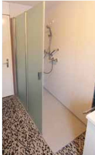
Nachher: Barrierefreie, rutschfeste, fugenlose Dusche mit wegfallender Duschtrennwand – pflegeleicht!
