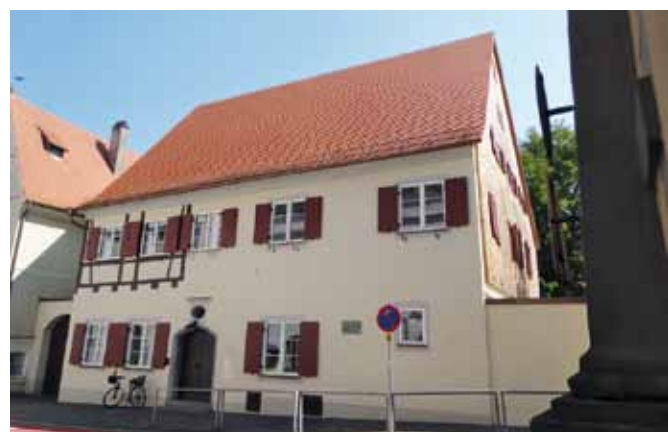
Mit dem Fassadenpreis wurde die Sanierung des Dekanatsgebäudes in der Zangmeisterstraße 13 ausgezeichnet.
