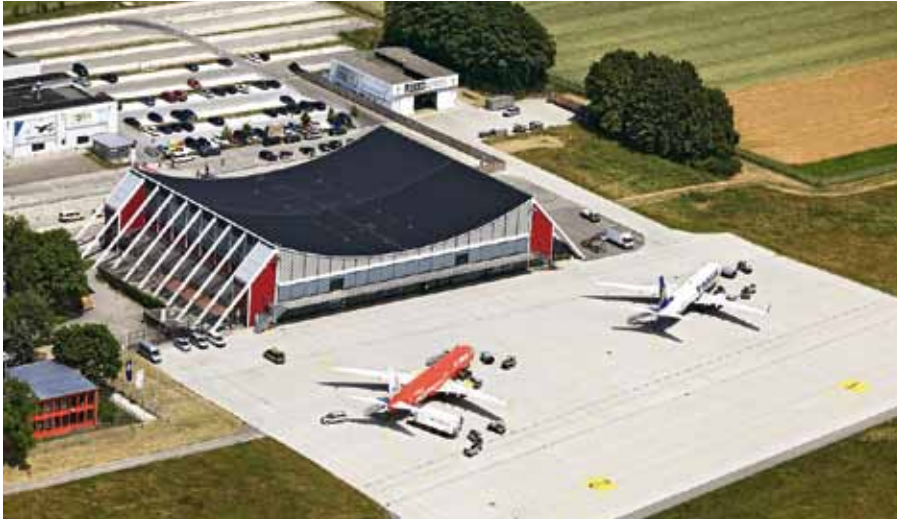
Durch Umzug und Neubau des Kabinenausstatters ACM entstehen weitere 120 Arbeitsplätze auf dem Airport-Gelände. Foto: dl-Archiv
