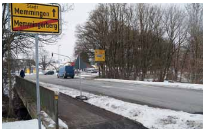
Im zeitigen Frühjahr steht der Neubau Haienbachbrücke an.
