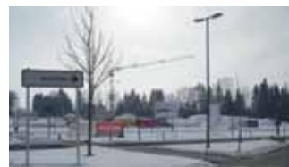
Ein modernes Büro- und Geschäftsgebäude errichtet die VR-Bank Memmingen auf dem Sondergebiet.
