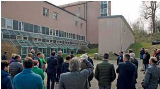
In Ottobeuren soll zunächst das alte Archiv im Westen des Krankenhauses (Gebäudeteil rechts im Bild) abgerissen werden. Der Baubeginn ist für November geplant.
