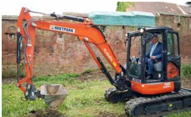
Im Rahmen der diesjährigen Bauvorhaben sind 1,5 Millionen Euro für die Stadtmauer- sanierung eingeplant. Foto: Stadt Memmingen
