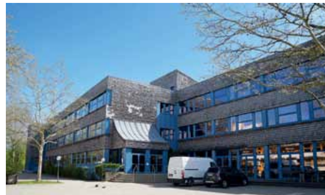
Die Teilsanierung der Johann-Bierwirth-Schule schlägt heuer mit 1,1 Millionen Euro zu Buche. Foto: Radeck
