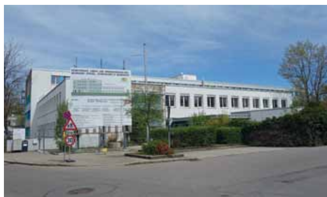
4,4 Millionen Euro sind in 2019 für die Sanierung des Bernhard-Strigel-Gymnasiums veranschlagt. Foto: Sonnleitner
